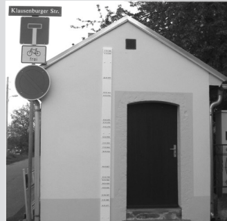
Hochwassermarken am ehemaligen Posthäuschen am Laubegaster Ufer / Klausenburger Straße
